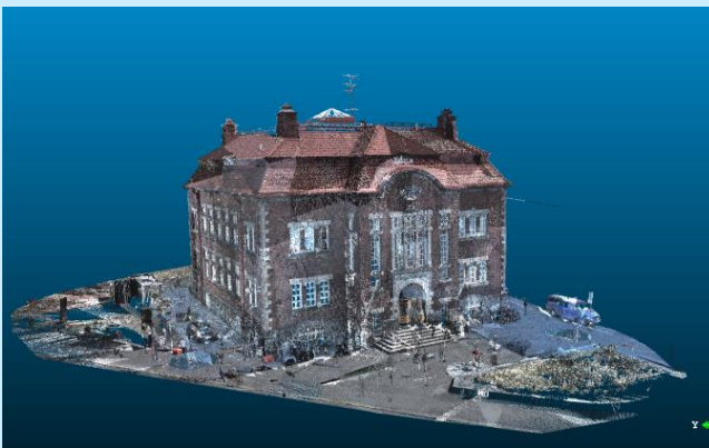
Julkisivuja värillisinä pistepilvinä
